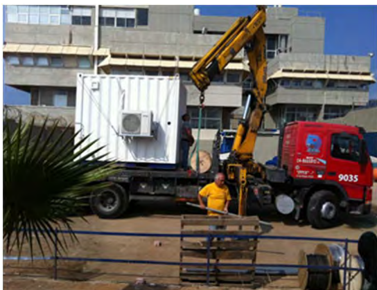
תמונות מס' 1-11 - חדרון המחשבים הנייד (חצי מכולה) שנרכש לצורך הצבה על מזח הפחם באשקלון
