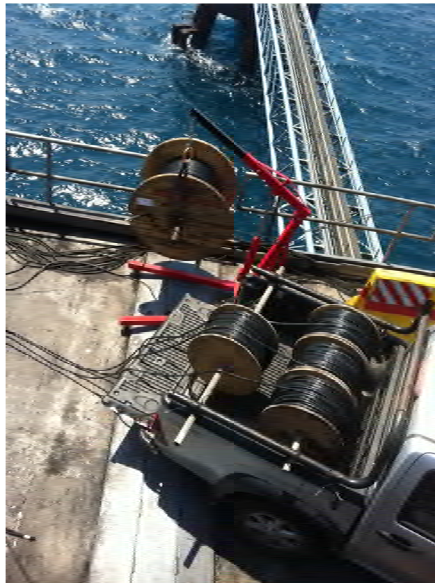
תמונה 1-17 – פריסת הכבלים של העברת נתונים על המזח כולל הכנסתם לצינור מגן לפי דרישות תקן חח"י
