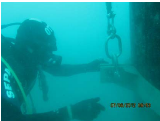
תמונות 1-14 - תכנית ויישום חיבור כבל ושרשרת מקרקעת הים על כלונס הדולפין ועד גג הדולפין לריתוק כבלי הנתונים
