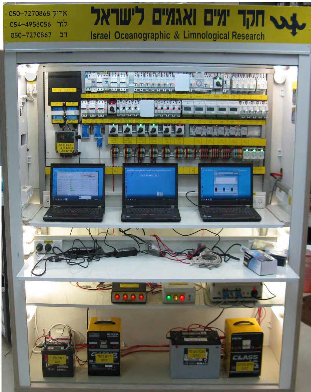
תמונה מס' 1-10 – ארון הציוד המחשוב לאגירה ועיבוד האותות, כולל גיבוי כח וסינון הפרעות רשת ושליטה מרחוק התכנון בוצע ויושם ע"י מנהל המחלקה לאקטרוניקה של חיא"ל, מר דון רמות
